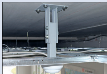
Bild 4: Verbauter Abhängestützen SST
